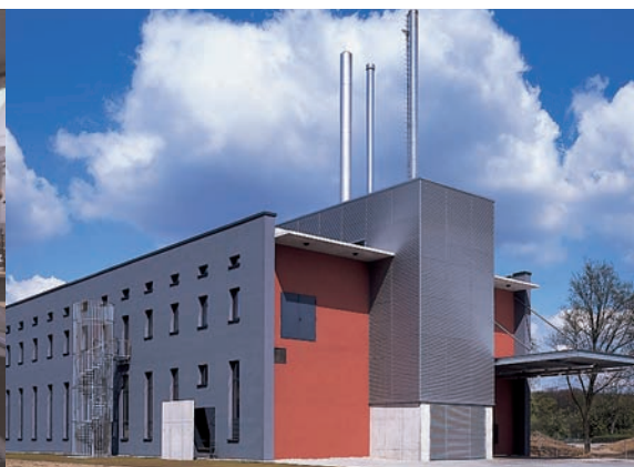
Les installations industrielles de traitement C. HAFNER sont parmi les plus modernes du monde
