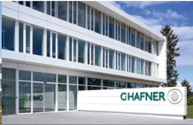
03 Das dreigeschossige C.Hafner Verwaltungsgebäude ist modern und modular konzipiert. Alles ist bewusst sachlich gehalten, als Ausgleich für ein so emotionales Produkt wie Gold
