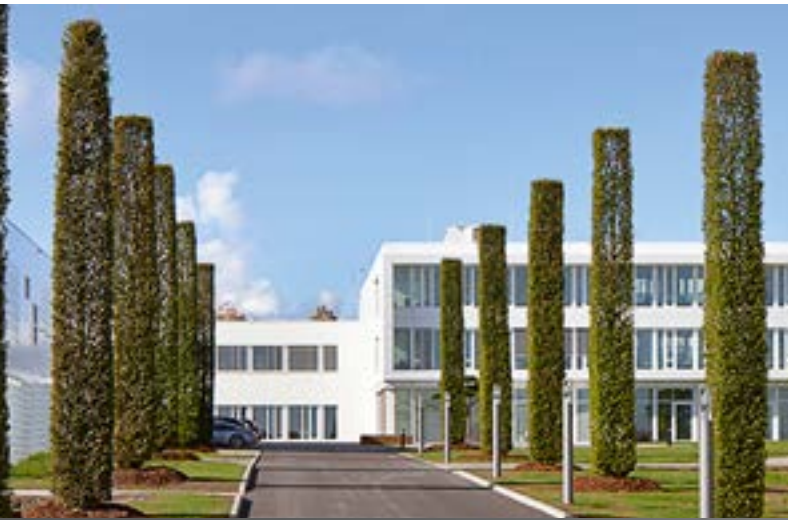
02 Zufahrt zum Gebäudeensemble von C.Hafner: Alleeartig säumen Hainbuchen die Zufahrt zum Unternehmen
